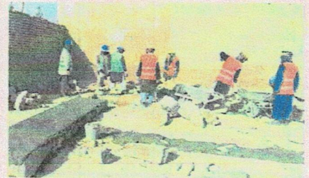
Seit drei Wochen läuft der Bau einer Schule in Masar-e Scharif. 20 Bauarbeiter sind hier beschäftigt. FOTO: BGZ
