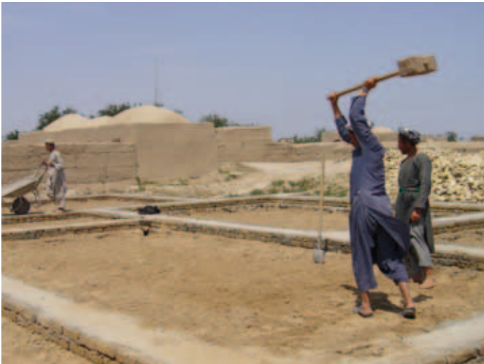
Bauarbeiten am Fundament einer neuen Schule in Yangitegerman (Bezirk Andkhoi)
